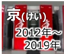
「京」 2012年～ 2019年 「京」、「富岳」設置場所：理化学研究所 (計算科学研究センター(R-CCS)) 兵庫県神戸市(ポートアイランド)
