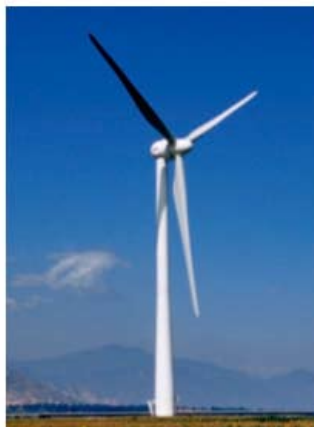
金風科技の1.5MW直接駆動式発電機
