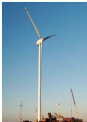
中鋼西重の1.5MW直接駆動式発電機
