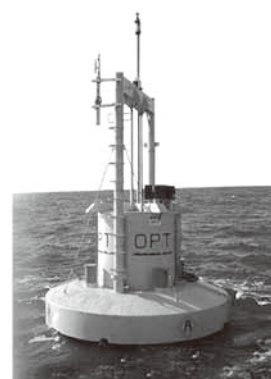
◎図12 PowerBuoy（米国、40kW）
