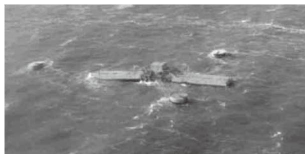
◎図6 波ポンプ（英国、400kW）
