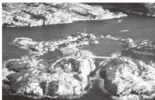
◎図9 タブチャン装置（ノルウェー、350kW）
