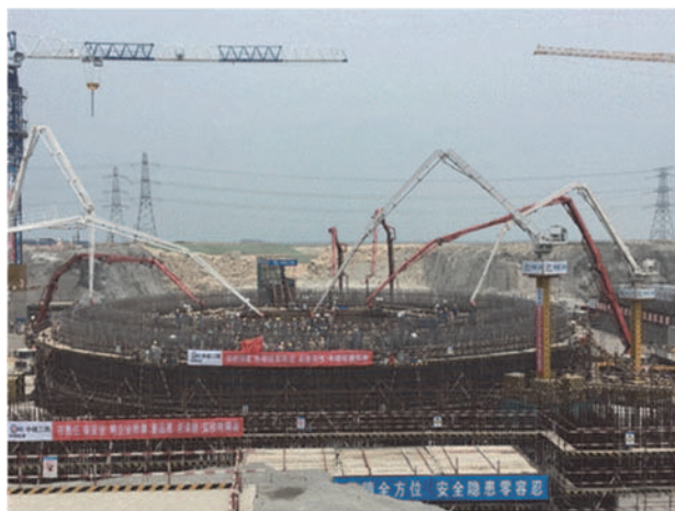
第1-4図 福清5号機の着工式
