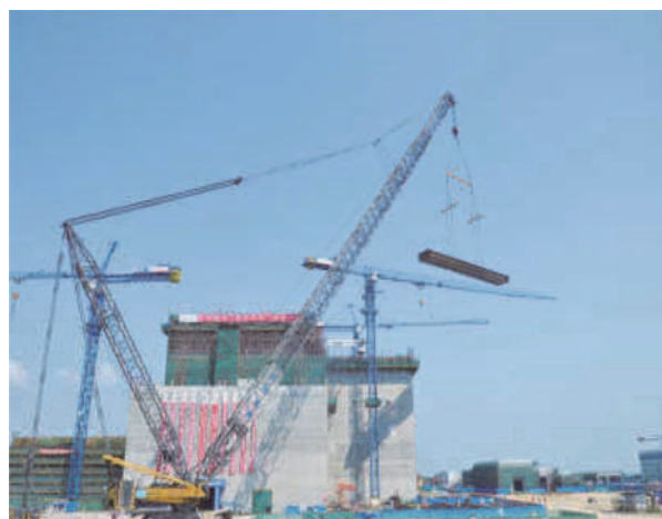
第1-17図 建設工事が進む高温ガス炉実証炉
