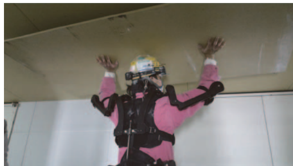
図1-3-9 浙江省寧波市で量産が開始された米国カリフォルニア工科大学カゼルーニ教授が研究開発した外骨格型ロボットによる建築作業支援の様子
