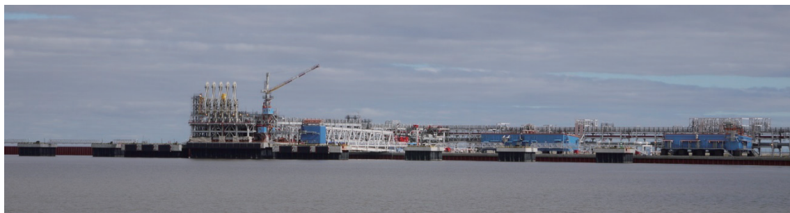
図11.5 ヤマルLNG基地の積出し栈橋（2018年、著者撮影）
