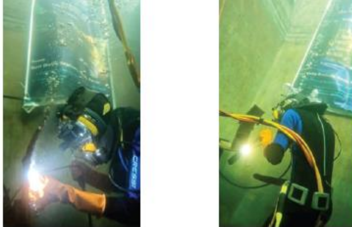
写真：水中溶接
