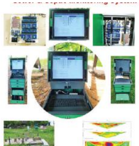
写真：下水浄化槽監視システム
