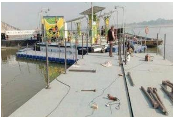
写真：世界初のボート用浮体式CNG充填ステーション。ウッタル・プラデーシュ州バラナシ、キルキヤ・ガート
